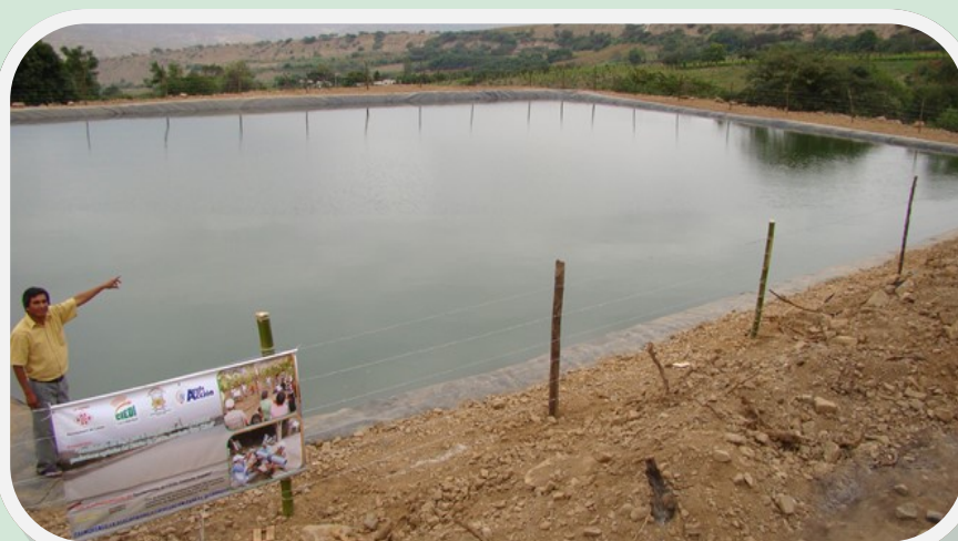
Vista panorámica de la obra construcción de Reservorio de 3100m 3 .
